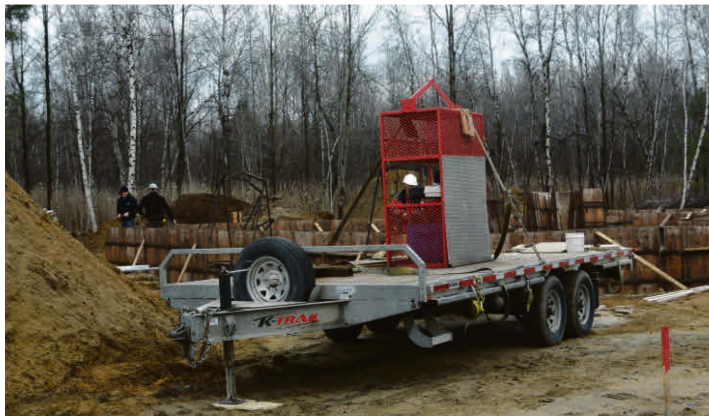
Le bilan annuel des activités de construction, émis par le Service de l'aménagement de la MRC d'Acton, indique un record d'investissements en 2021, avec un montant total de 58,7 millions $.
