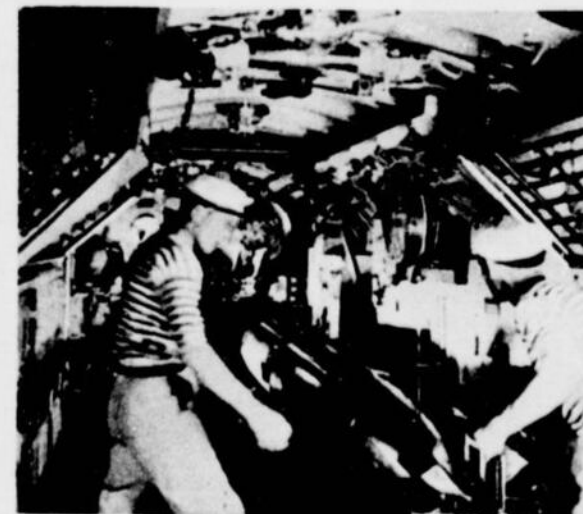
Voici la torpille telle qu'elle apparaît. Elle est projetée hors du tube par l'air comprimé. Aussitôt libre, elle est mue par son propre moteur qui se déclenche au moment du lancement
