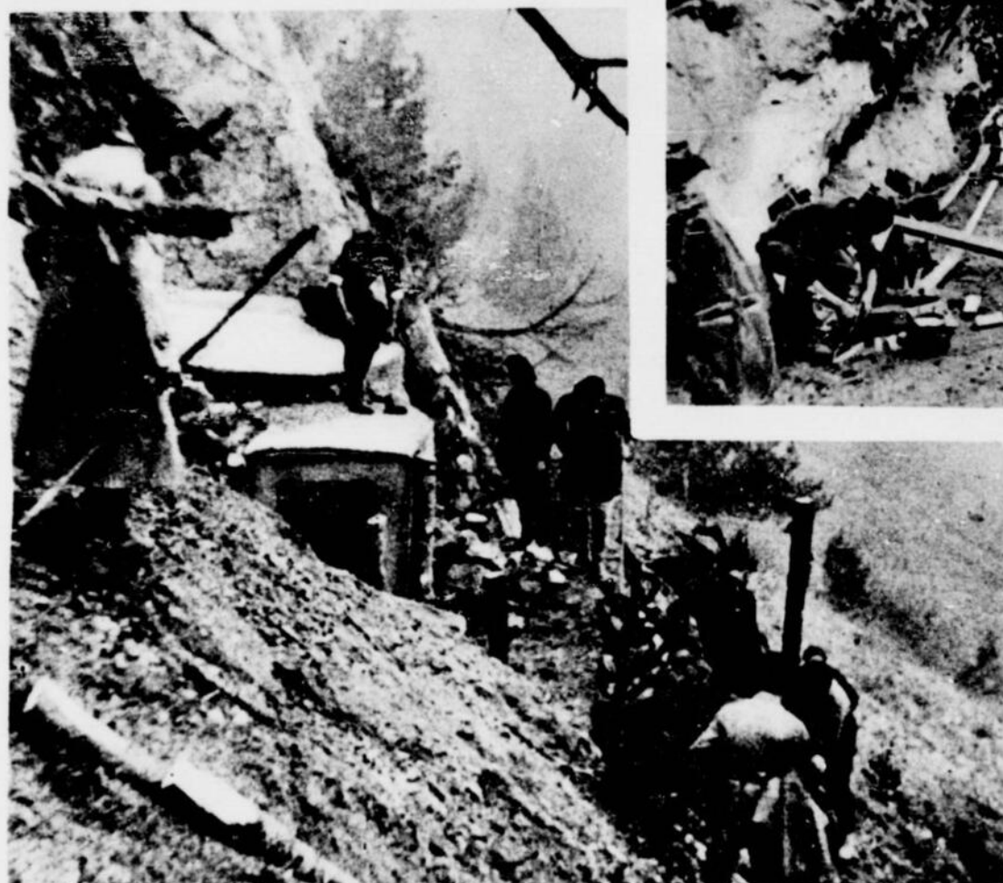
En pleine montagne, les recrues bâtissent des fortifications solides et établissent des bases de béton pour les canons.
