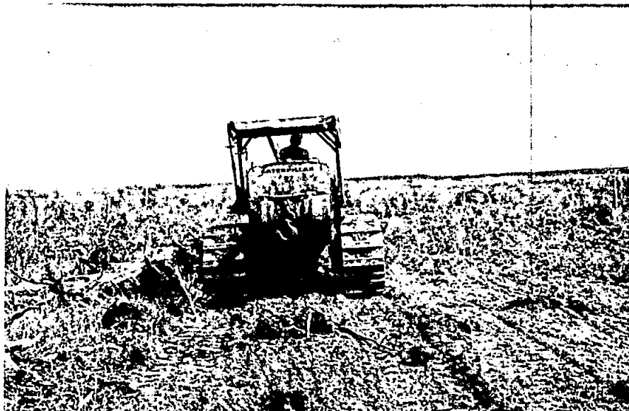
Figure 11 Scarification du sol à l'aide d'un tracteur à chenilles afin d'éliminer la végétation existante et de briser les souches en voie de pourrissement
