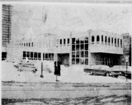
Vue d'ensemble du nouvel hôtel de ville ainsi qu'une partie du poste de police et pompiers. Photo prise sur la rue Sherbrooke...
