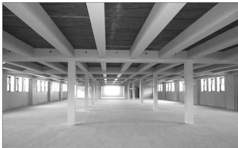
On peut notamment se réjouir de la conservation d'éléments architecturaux intéressants, tels les plafonds de bois du premier étage datant des années 1960.
