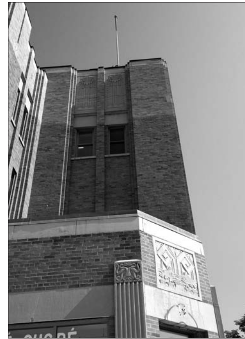
L'extérieur du Marché Saint-Jacques a été bien conservé, notamment ses bas-reliefs, mais les briques posées en haut des murs en 1997 tranchent avec les briques d'origine.
