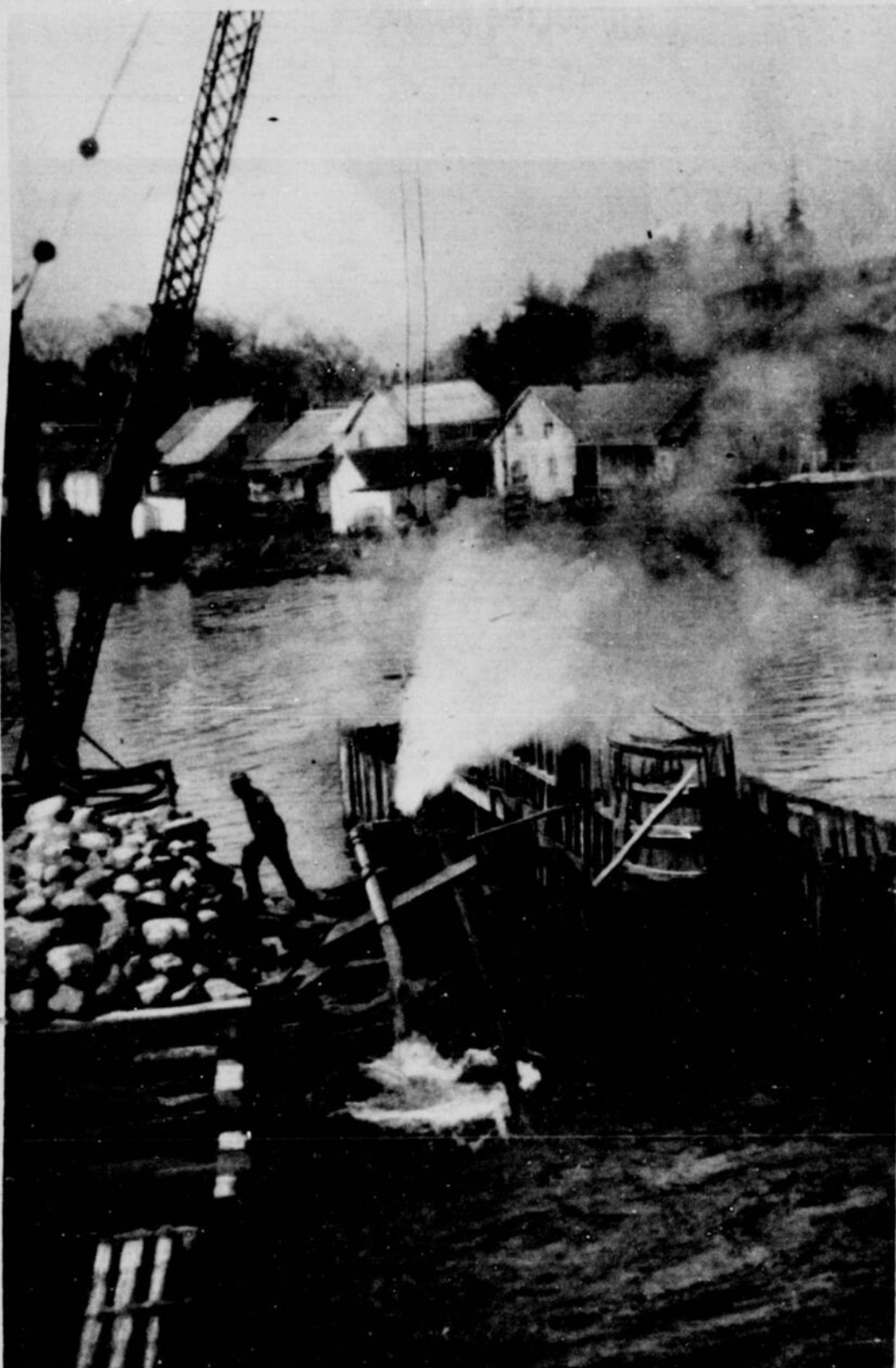
Que de pontons, comme ceux-ci, il faut poser afin de raccourcir la voie et de conserver sa ligne droite
