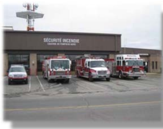
Caserne nord (790, de la Mairie, Blainville)
