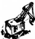
DÉBUT DES TRAVAUX 26 DEC. 1940
