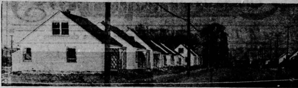
Belle perspective de maisonnettes en voie de construction par la firme L.-E. Price, rue Berri et Kelly. On voit au loin, le viaduc des voies élevées du C.N.R. Le solage de ces constructions est établi avec soin. La nécessité oblige à faire vite, pour loger les milliers de familles actuellement sans logis convenable, et pour assurer un foyer invitant, aux jeunes couples mariés du printemps. (Photo la "Patrie").
