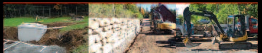
INSTALLATION DE FOSSE SEPTIQUE
