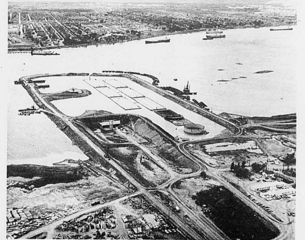
Tel est l'aspect qu'offrait le chantier de construction du tunnel Lafontaine à la fin de mai 1965. La cale avait été inondée et les sept éléments préfabriqués attendaient d'être amenés vis-à-vis leur emplacement définitif au milieu du fleuve. On aperçoit aussi l'entrée des deux tubes de circulation du côté sud.
