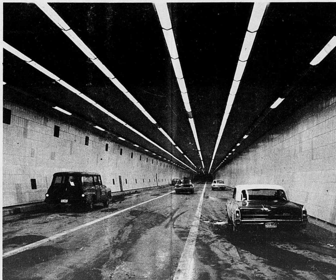
Vue générale d'un tube de circulation du tunnel et de ses trois pistes de roulement d'une largeur totale de 38 pieds. Les murs sont recouverts de carreaux céramiques blancs, tachés ici et là de carreaux de couleur ocre pour rompre la monotonie.
