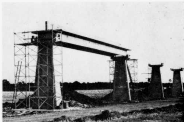
La voie en « T » inversé repose sur les piles ; elle est constituée d'éléments en béton armé précontraint, de vingt mètres de longueur.
