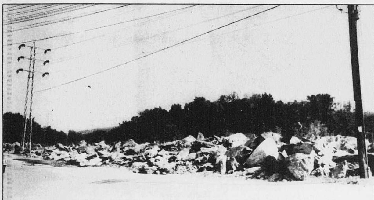
La Ville abandonne l'idée d'utiliser de grosses pierres pour protéger l'île des Soeurs de l'érosion. Elle pourrait draguer le fond de la rivière Saint-François en amont de l'île pour faciliter le passage des glaces au printemps.
