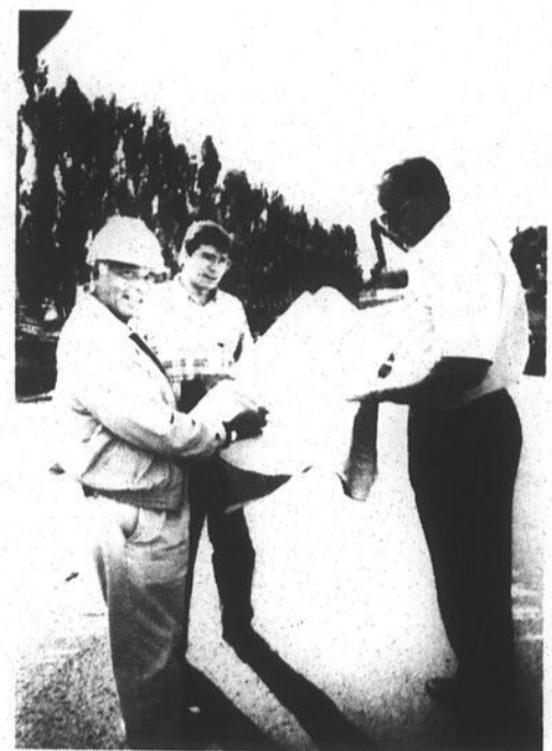
Sur notre photo, l'ingénieur Robert Mallamo, surveillant de chantier chez RBI Experts-Conseils, examine les plans des travaux du Grand-Bernier en compagnie du chargé de projet, l'ingénieur Éric Genest, sous l'œil attentif de Luc Rivard, ingénieur et directeur de l'exploitation chez P. Baillargeon Ltée. (photo Jacques PAUL)
