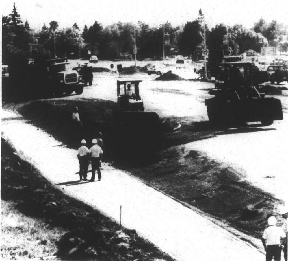
On ne s'y reconnaît peut-être pas, mais cette photo représente une partie du boulevard du Séminaire devant l'hôtel Vallée des Forts où se poursuit le plus important chantier de l'été à Saint-Jean-sur-Richelieu. (photo Jacques PAUL)
