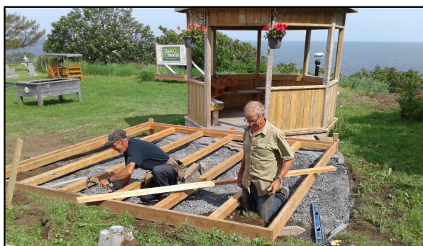
Bruno et André, de Rénovations Bélanger inc., en train de construire la plate-forme de danse. photo : Luc Carey
