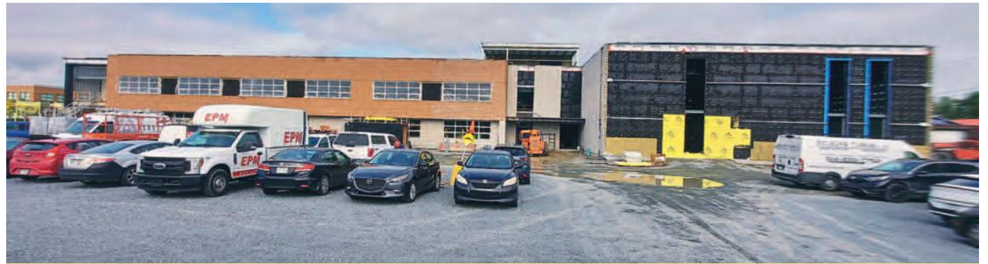
Le réaménagement des espaces entourant l'école secondaire le Carrefour, à la suite des travaux d'agrandissement, fait craindre aux élèves de l'école et à leurs parents la perte d'importants espaces verts.
