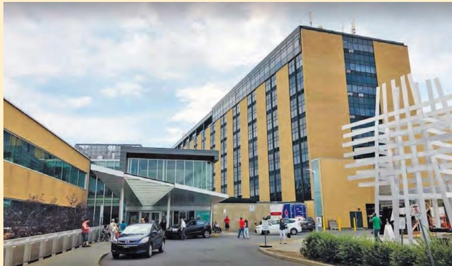
À Longueuil, trois salles d'opération sur dix sont inoccupées à l'Hôpital Charles-Le Moyne, alors que 30 lits ne sont plus disponibles.
