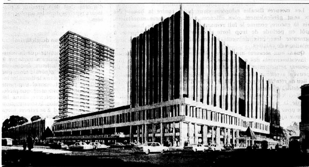
Maquette de la Plaza Alexis Nihon, complexe immobilier commercial et résidentiel au coût de $30 millions et situé aux coins des rues Ste-Catherine, Atwater et Western à Westmount et Montréal. Le gros-oeuvre de la première phase du projet: le Mail, vient tout juste d'être terminé. Un parc-autos pouvant abriter 1,500 véhicules surplombe les trois étages du mail lesquels comprendront des boutiques, grands magasins, cinéma et restaurants.
