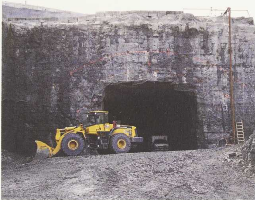
La station De la Concorde en construction. (Agence métropolitaine de transport)
