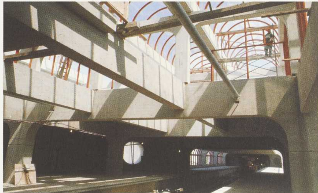
La station Angriçon en cours de réalisation. (Archives de la STM)
