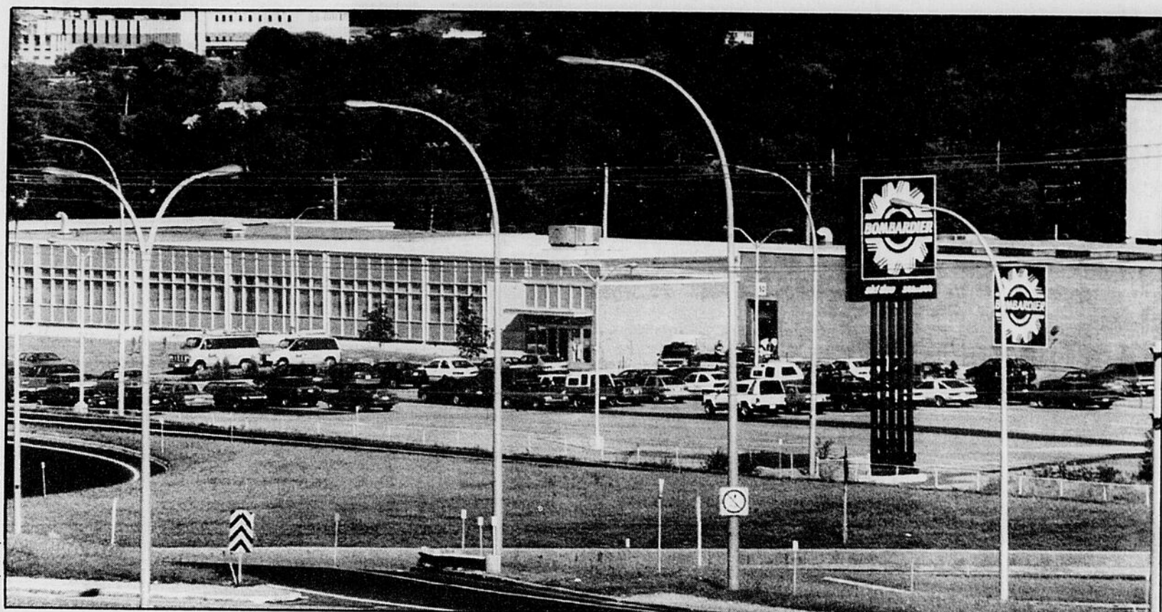
L'ouverture officielle aura lieu dans un peu plus d'un mois, mais déjà l'activité ne manque pas aux nouvelles installations de Bombardier à Sherbrooke. La compagnie indique clairement sa présence d'ailleurs grâce aux enseignes qui l'identifient.
