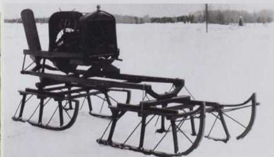
C'est avec un moteur de Ford T que Joseph-Armand Bombardier a créé son traîneau à hélice
