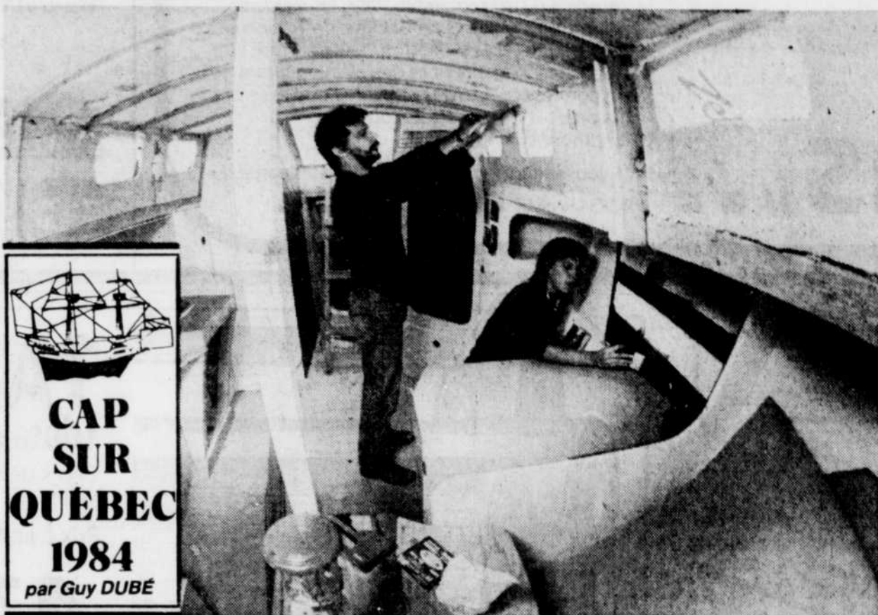
La finition intérieure achève: André voit à l'installation des hublots et Martine vernit le céder. Ce sera leur demeure pour les quatre ou cinq prochaines années.
