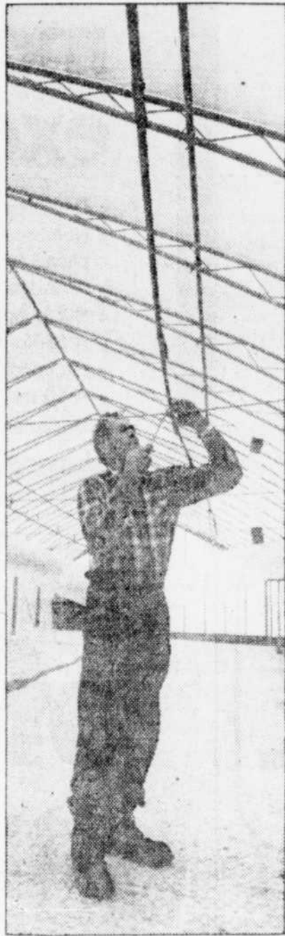
Un ouvrier s'affaire à monter une des nouvelles serres.
