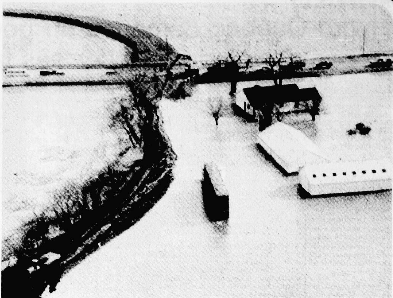
DIGUES — Des fermiers ont uni hier leurs efforts des eaux à l'embouchure de la rivière Thames près pour réparer une digue qui a cédé sous la pression de Windsor, Ontario.
