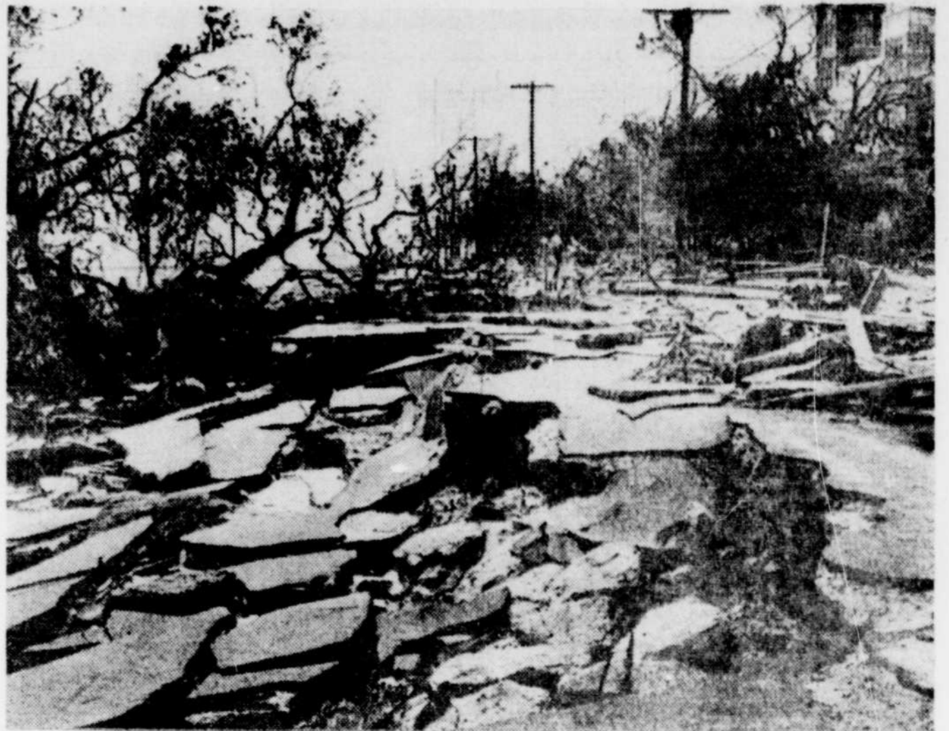
PLUSIEURS DEGATS, DONT ON NE CONNAIT pas encore l'étendue exacte des dommages, ont été causés à la suite
