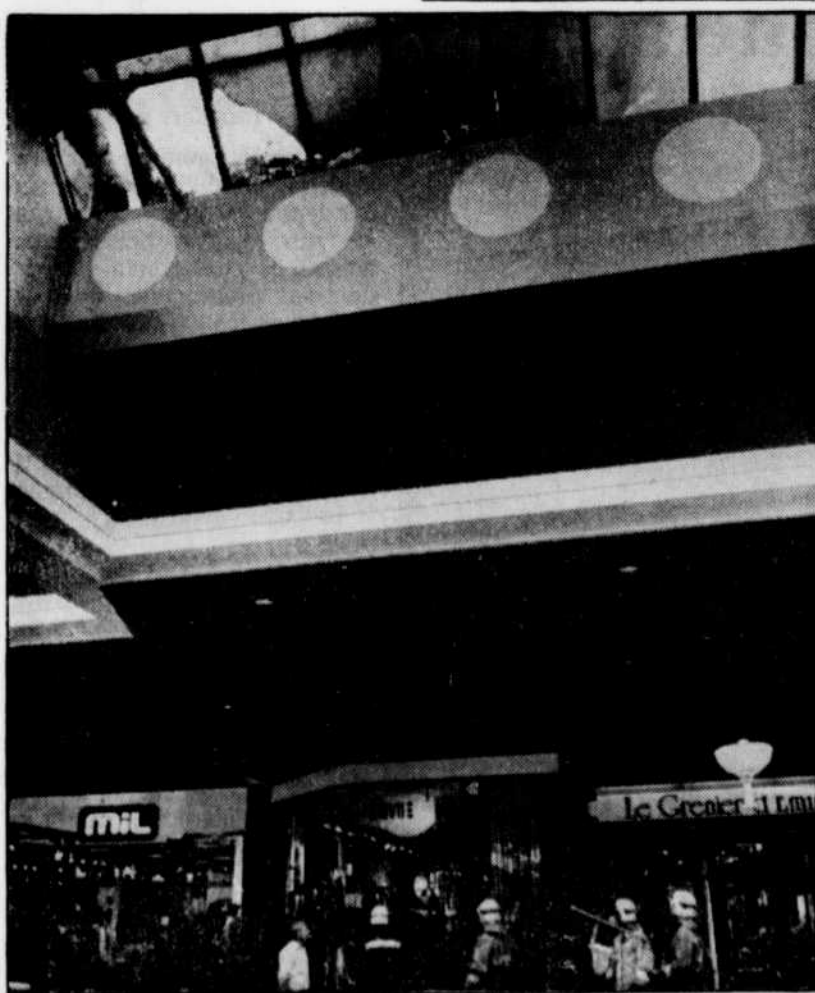
On voit de l'intérieur une partie de la toiture que les ouvriers étaient en train de réparer. Annie Renaud (ci-dessus), dont la boutique a subi les dommages les plus importants, s'estime malgré tout chanceuse.
