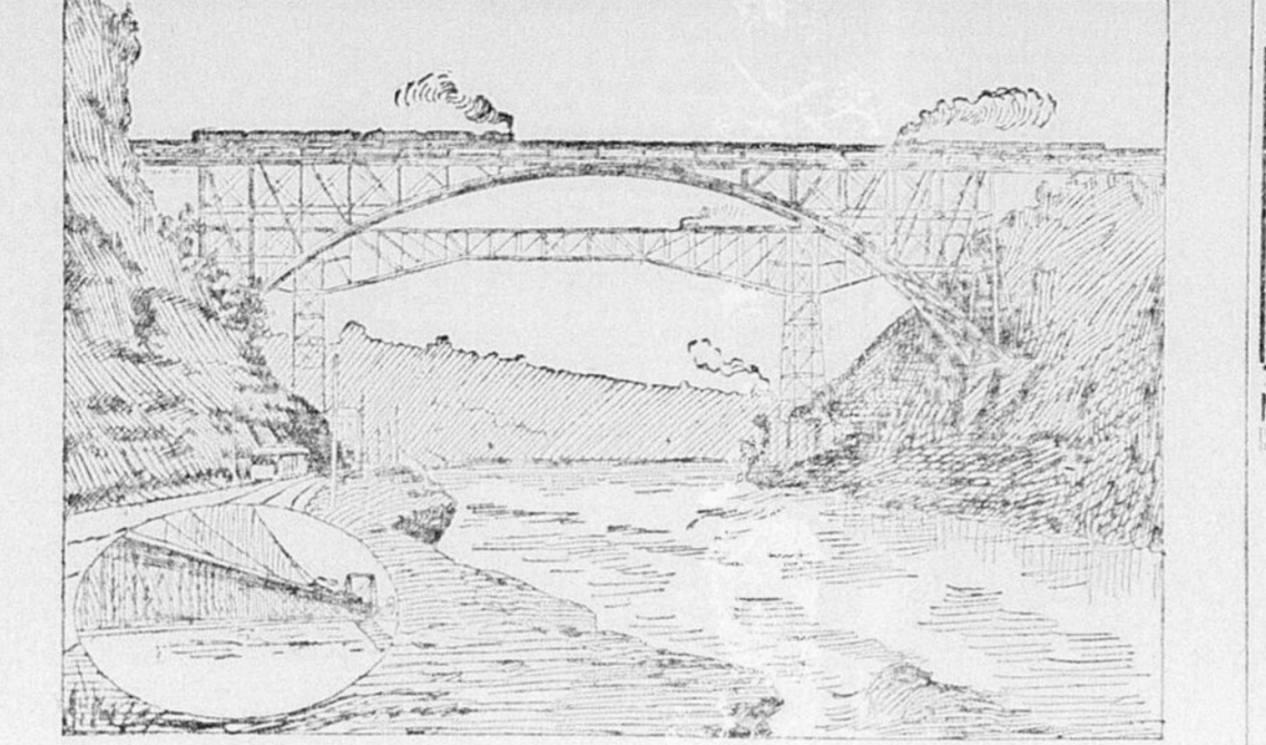
Le pont du Grand-Tronc sur le Niagara
