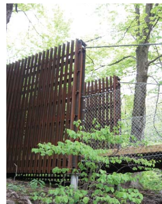
PASSERELLE DE LA RIVIÈRE SAINT-CHARLES AU SUD DE L'ORETTEVILLE CROFT PELLETIER ARCHITECTES
