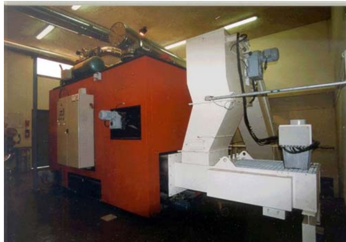
Photo 22 : Trémie doseuse avec poussoirs
