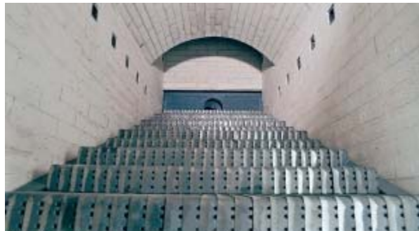
Photo 23 : Chambre de combustion en escalier
