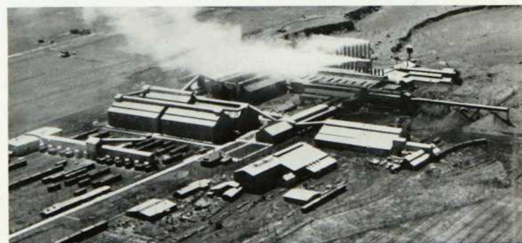
Vue aérienne de l'usine de la Canada Cement Co. Ltd., dans le quartier est de Montréal.
