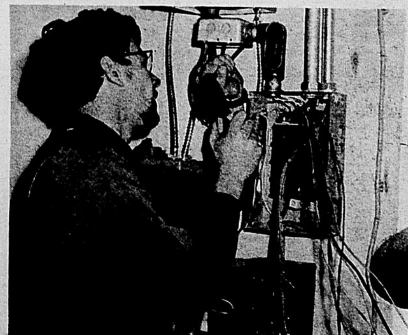
M. Michel Métivier, de qui releva l'exécution des travaux d'électricité.
