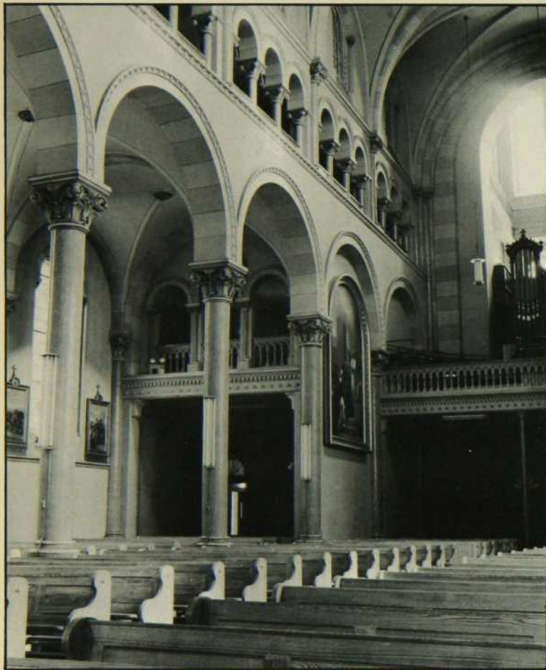
Les sources romanes de l'architecture de Victor Bourgeau, dans le cas de cette chapelle, sont particulièrement évidentes comme on peut le voir sur cette photo.
