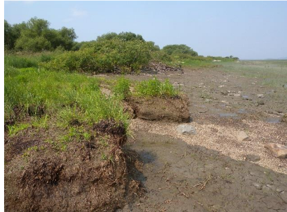
Figure 5 Ligne de rivage en érosion, haut marais, est du quai de Montmagny
