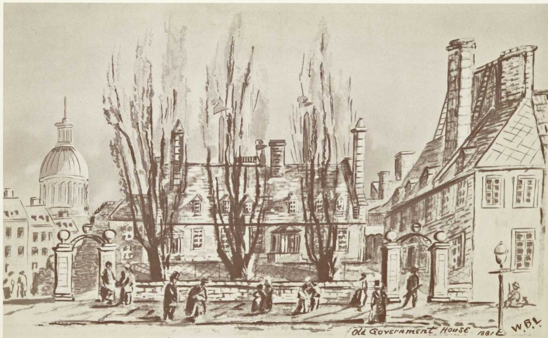
Le Château de Ramezay tel que modifié pour les besoins temporaires du Palais de Justice en 1848-1855 avec son aile ouest.
