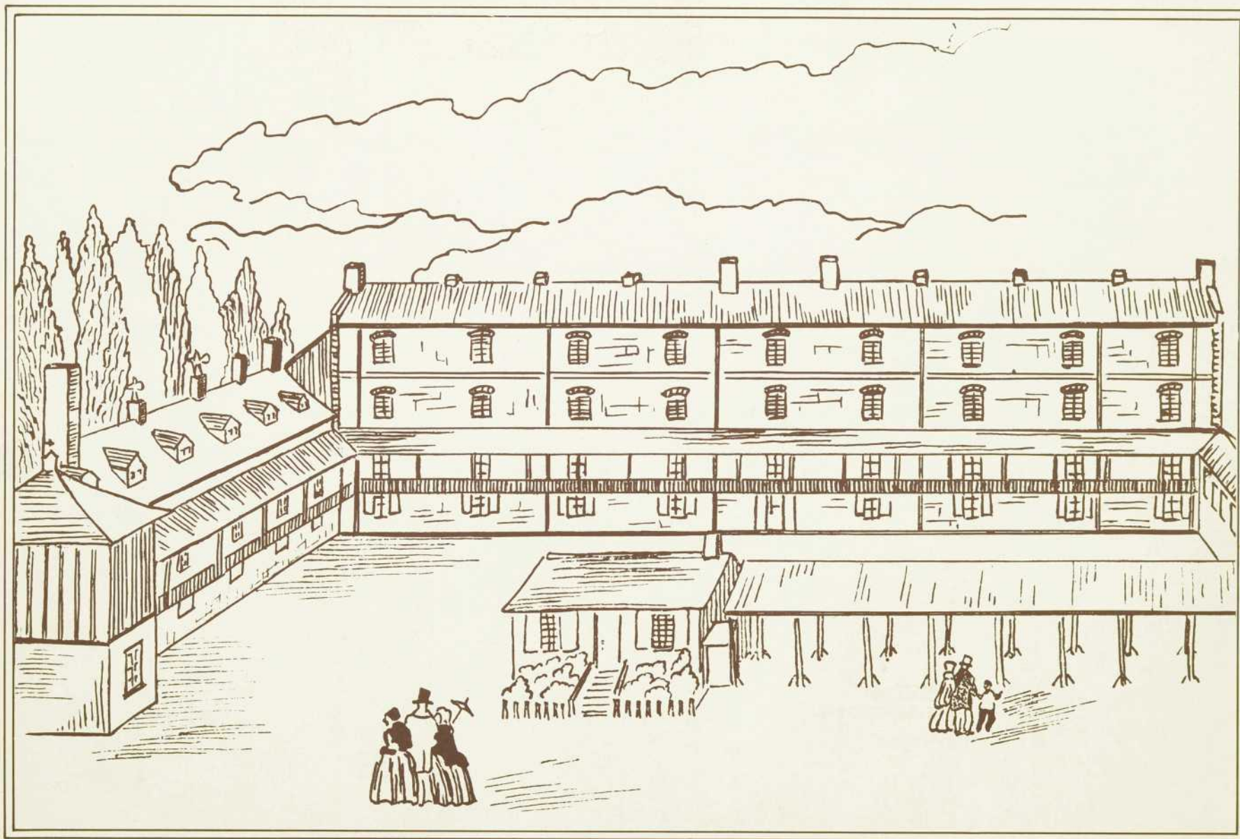
La cour intérieure du Château, avec l'aile temporaire de la rue Saint-Claude, qui fut occupée par le Palais de Justice (1848-1855) L'Ecole Normale (1856-1878), l'Université (1884-1889) et la Cour des Magistrats (1889-1892).
