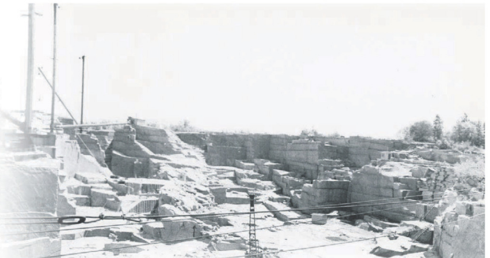
Carrière de granit de la Société Fairmont Granit, appartenant à la Brodies Limited, à Guénette.
