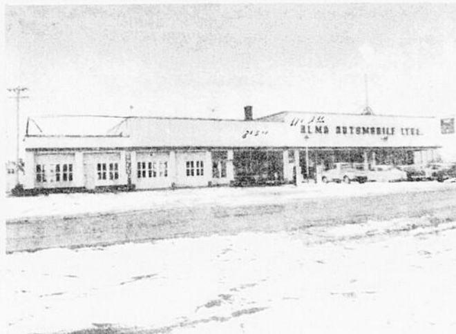
Nous voyons ici le garage avant que d'importantes rénovations soient apportées.
