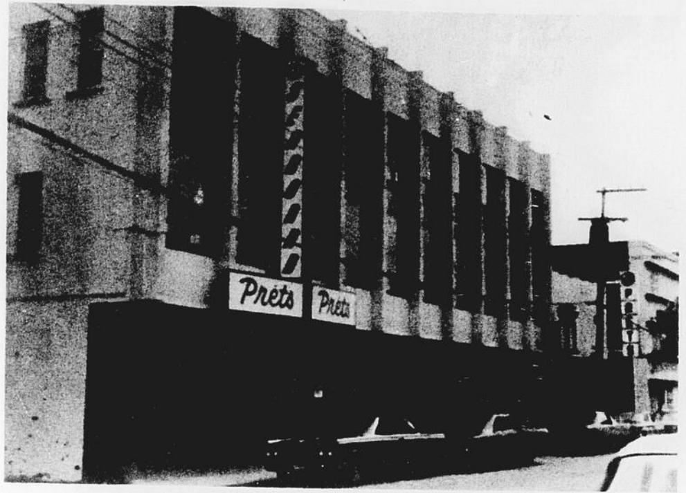
La façade du Magasin Parisien après la rénovation de 1965.
