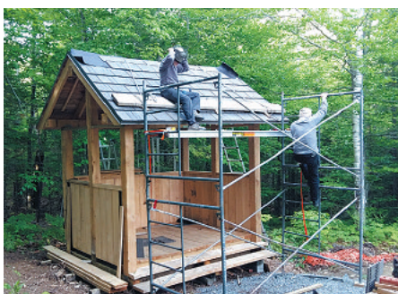
Le kiosque d'accueil en construction
