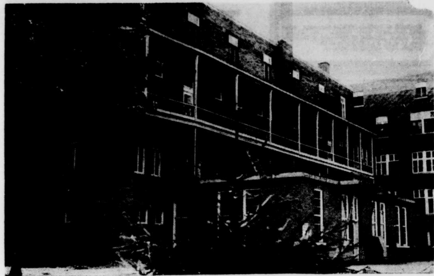
L'AILE NORD DE L'HOPITAL SAINT-JOSEPH DE LA TUQUE, sera démolie, d'ici quelques jours, pour faire place à un vaste terrassement. Cette partie de l'hôpital, pratiquement abandonnée depuis 1963, ne correspondait plus
