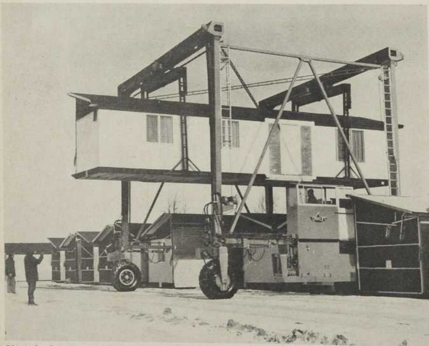
Vue de la grue mobile transportant une unité préfabriquée, c'est-à-dire une demi-maison.
