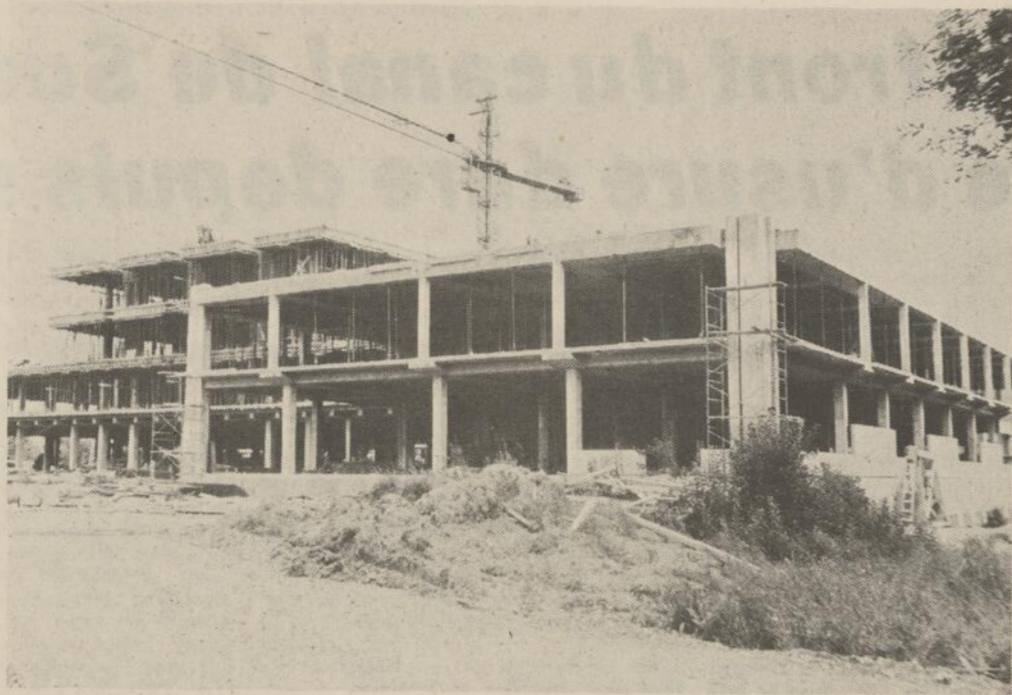
HOPITAL HONORE MERCIER - Les employés du chantier de l'hôpital Honoré-Mercier, qui s'élève à l'arrière de l'actuel hôpital général de Saint-Hyacinthe, en sont à monter le troisième étage de l'édifice, qui en comptera neuf une fois terminé. C'est la compagnie Sogela qui se charge de cette construction au coût de plus de $12,000,000. Le nouveau complexe hospitalier et chirurgical pourra disposer de 350 lits, en comparaison de 270 que compte l'hôpital actuel. (Photo Bernard Saint-Pierre)
