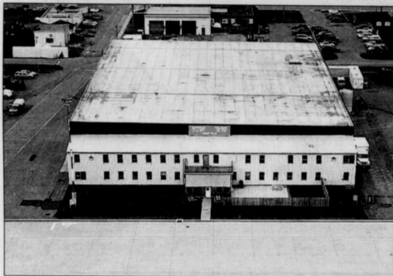
Le ministre Jean-Pierre Blackburn est formel : les travaux de reconstruction du hangar 2 de Bagotville commenceront en 2012.
