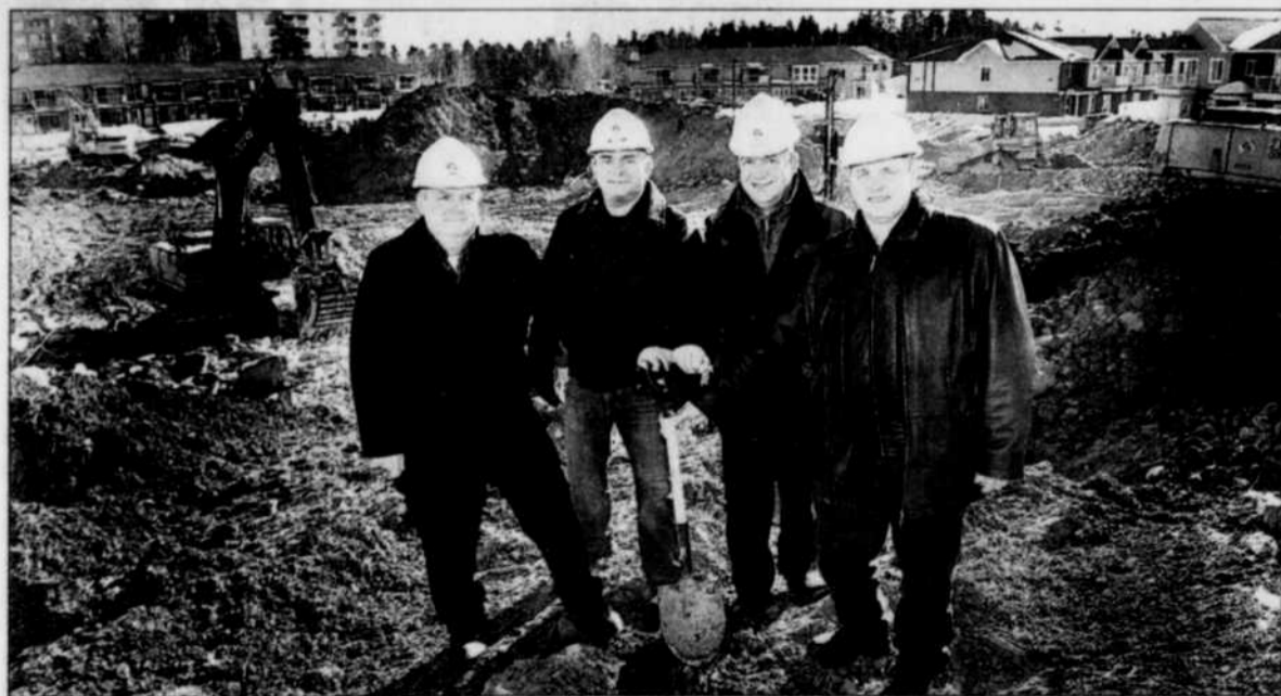
Gaétan, Guy et Réjean Boivin ainsi que Louis Sénécal ont procédé à la première levée de terre du projet résidentiel Place Alfred-Boivin, un investissement de 5,5 M$.
