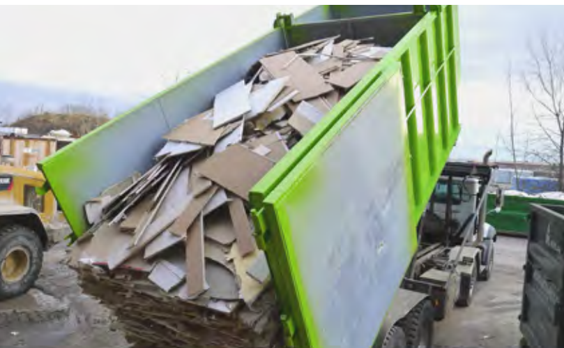
◀ Un conteneur recueillant les résidus de gypse sur le chantier. Photo : 3R MCDQ
