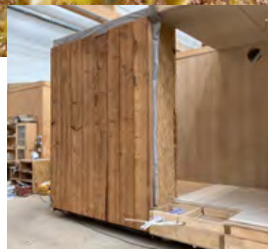
◀ L'assemblage en atelier des modules du bâtiment UP STRAW. Photo : helium3 architectures
