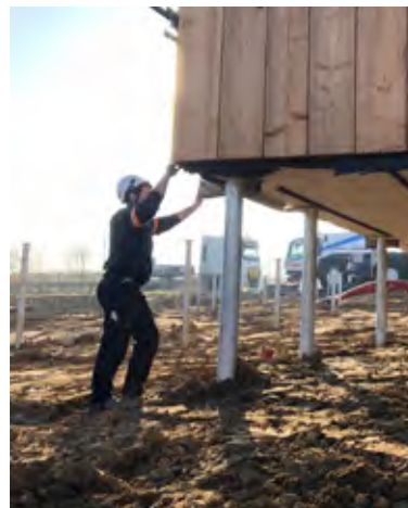
▲ La pose sur pieux des modules du bâtiment UP STRAW. Photo : D. Vasilov
