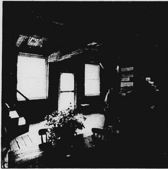
Ci-contre, les Quig devant le moulin Denison restauré; ci-dessous, vue de la salle de séjour montrant les murs intérieurs en brique et les poutres du plafond, de 14 pouces sur 14, qui ont été équarries jadis à la hache.
