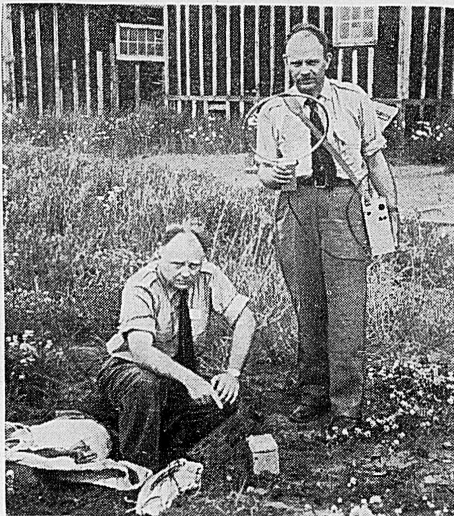
Voici un nouvel appareil de repérage des feux de forêt. La petite boîte, sur le sol, est en réalité un poste émetteur. L'avion qui patrouille les forêts pour découvrir tout lieu d'incendie laisse tomber en parachute ce poste émetteur petit, mais assez puissant. Chaque équipe, au moyen d'un poste récepteur muni d'une antenne, peut ensuite se diriger avec certitude vers le foyer de l'incendie, sans se laisser tromper par la fumée.
