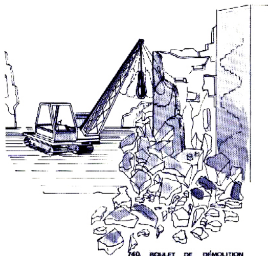
740. BOULET DE DÉMOLITION
