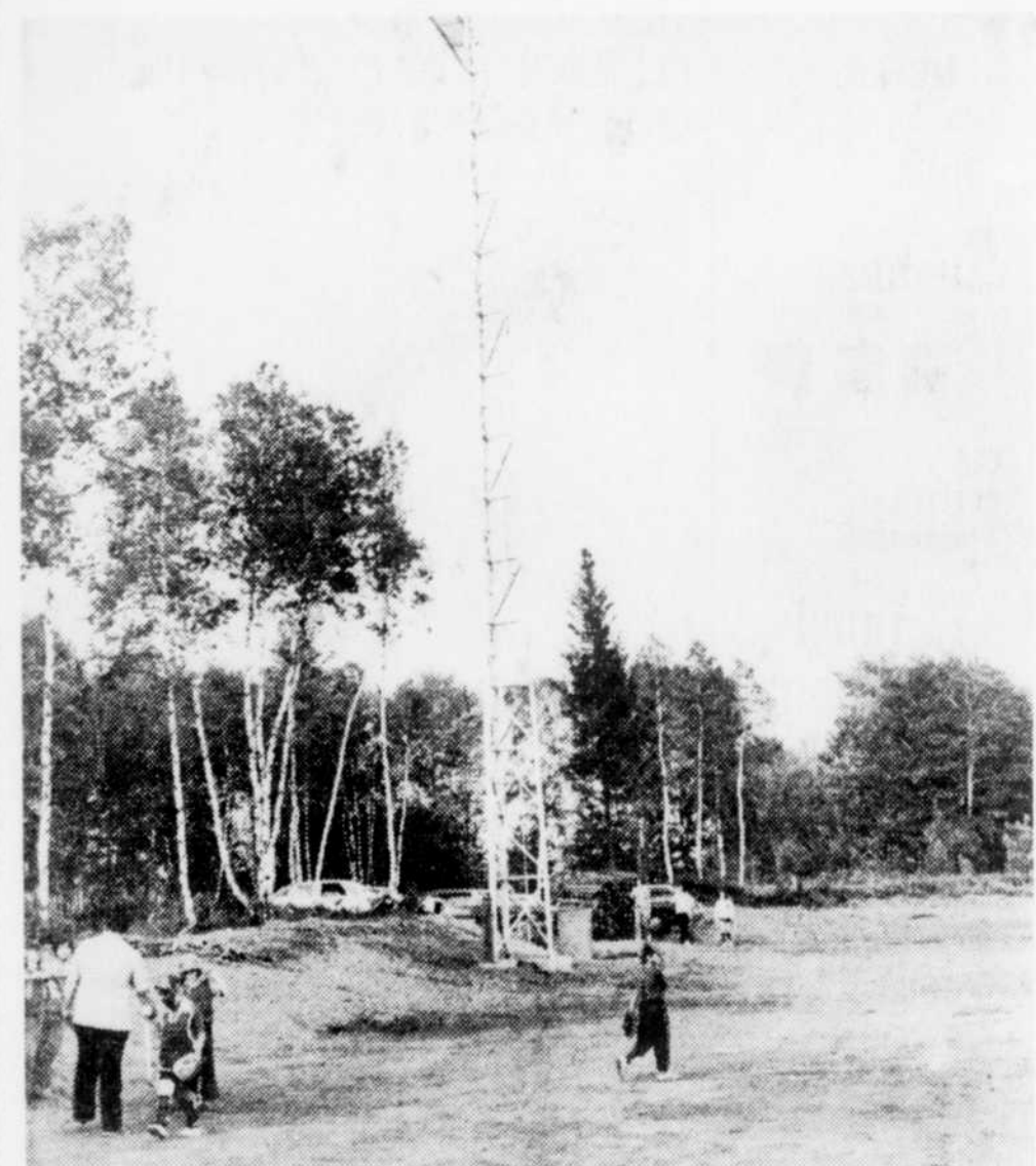
JEUX DANGEREUX — Depuis l'installation des pylônes du système d'éclairage du terrain de baseball du Parc Central de Rock Forest, plusieurs enfants ont été vus alors qu'ils escaladaient les structures. Les autorités de la municipalité déplorent ces faits et elles ont pris des mesures pour intensifier la surveillance de ces lieux. Malheureusement il semble que plusieurs enfants réussissent à échapper à la surveillance exercée. Les parents sont invités à informer leurs enfants des dangers que représente pour eux, l'ascension de ces hautes de 65 pieds. (Photo La Tribune, JB, Rock Forest)
