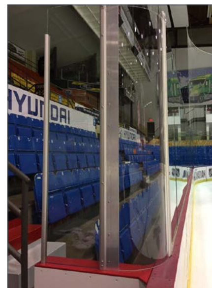
Les nouvelles baies vitrées arrondies installées au Centre Marcel-Dionne.
