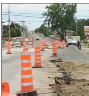
La route 139 a fait l'objet de travaux entre le boulevard Saint-Joseph et l'autoroute 55.
