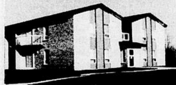
Résidence située sur le terrain du collège
