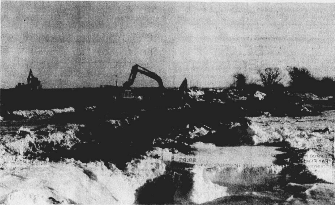
L'ampleur des travaux se voit très bien en regardant le complexe le long du chemin Connaught. Trois immenses bassins y seront aménagés.
