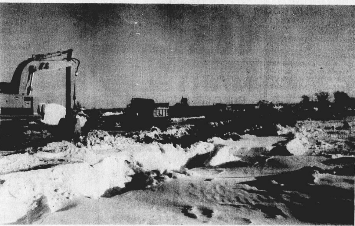
Des pelles, des camions, ces pièces d'équipement sont en très grand nombre sur le site d'aménagement des bassins. C'est ce que l'on peut appeler de la circulation lourde.
