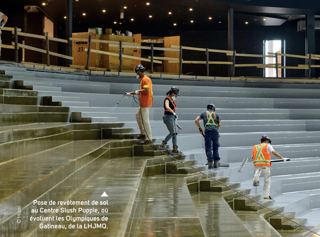
▲ Une fois l'épandage des flocons décoratifs terminé, ceux-ci sont clairement visibles à travers la couche de scellement et le liant à base de résine époxyde.
