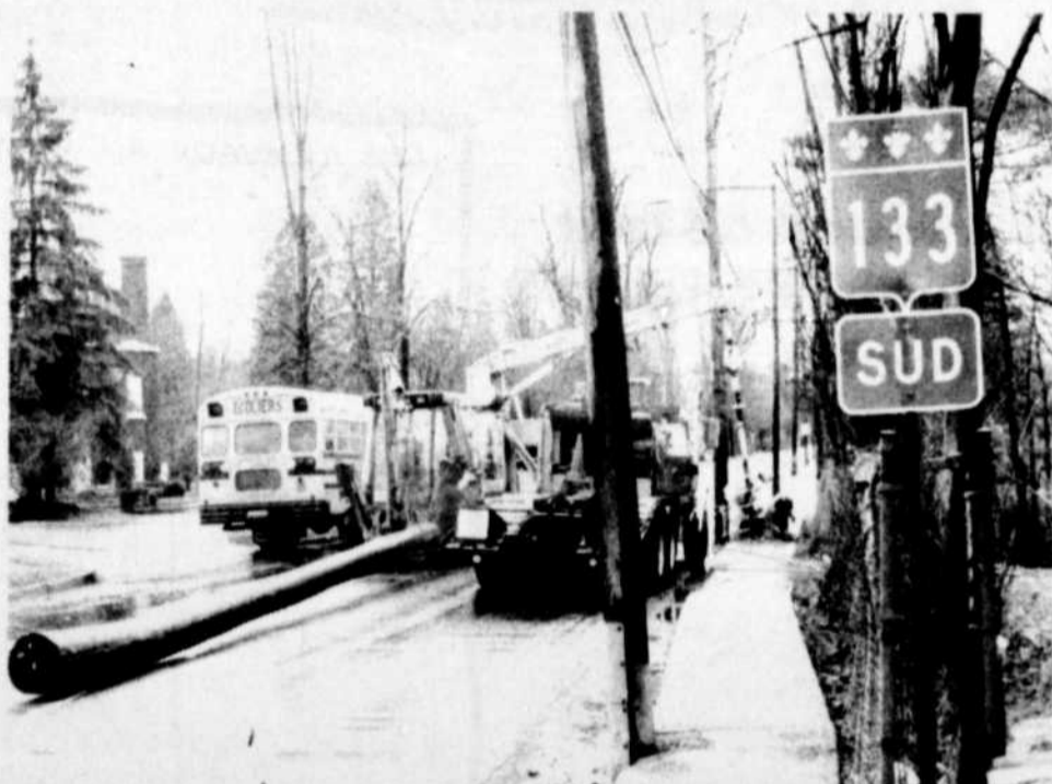
Hydro-Québec a donné le coup d'envoi aux travaux de réfection du chemin des Patriotes Sud, le 9 avril. Les automobilistes ont eu un avant-goût de ce qui les attend durant la période estivale, alors que des tronçons de la route ont été fermés à la circulation cette semaine.
